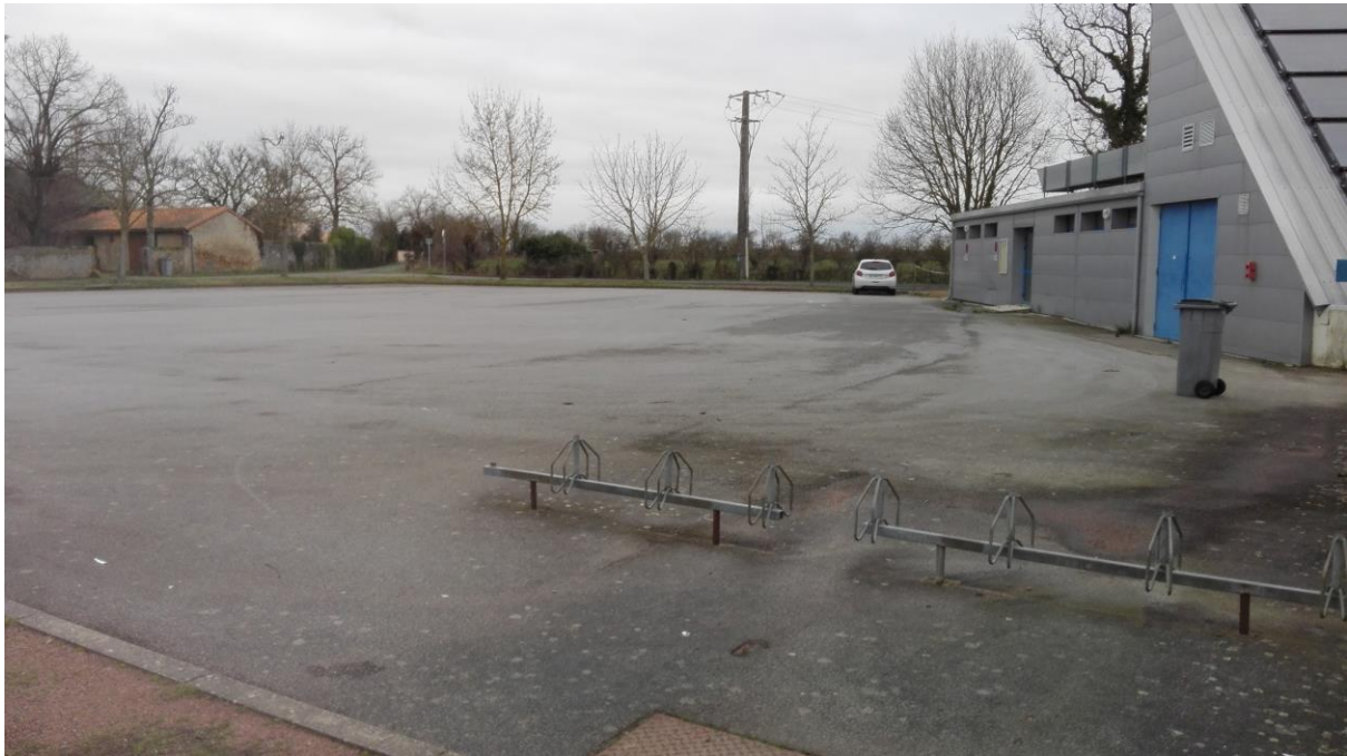
Figure N°50 - Parking de la piscine de Saint Varent
